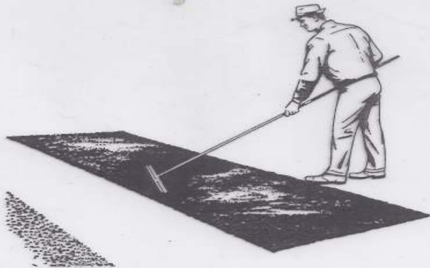
(d) Spreading the mix
