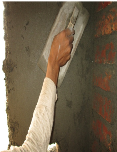
Fig: Leveling & Smoothing
