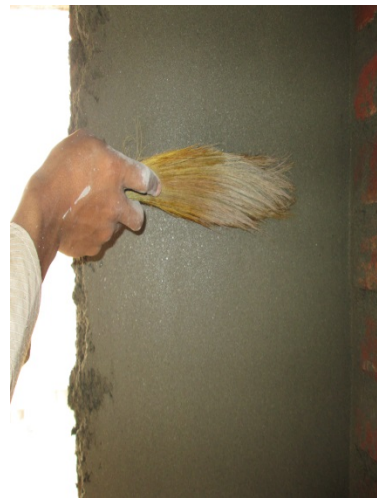
Fig: Leveling & Smoothing
